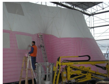
Aplicación sobre un soporte del tipo de espuma de poliestireno u otro.
